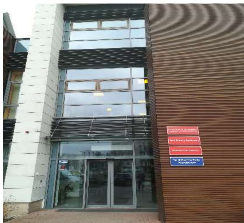
Zdj. 1. Widok na drzwi wejściowe
